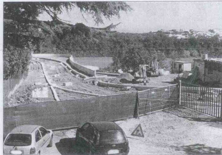
Vista della strada a doppio senso per transito pullman e carreg. sinistra per la Valle dei Casali
