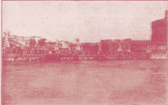
Gli archi del ponte Sant'Angelo ormai completamente chiusi dall'acqua.
