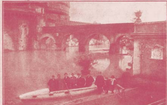
Viadotto che unisce Castel Sant'Angelo col Vatinaso.
