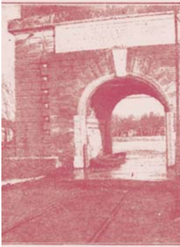
L'acqua entra dall'arco-porta di Ponte Milvio.
