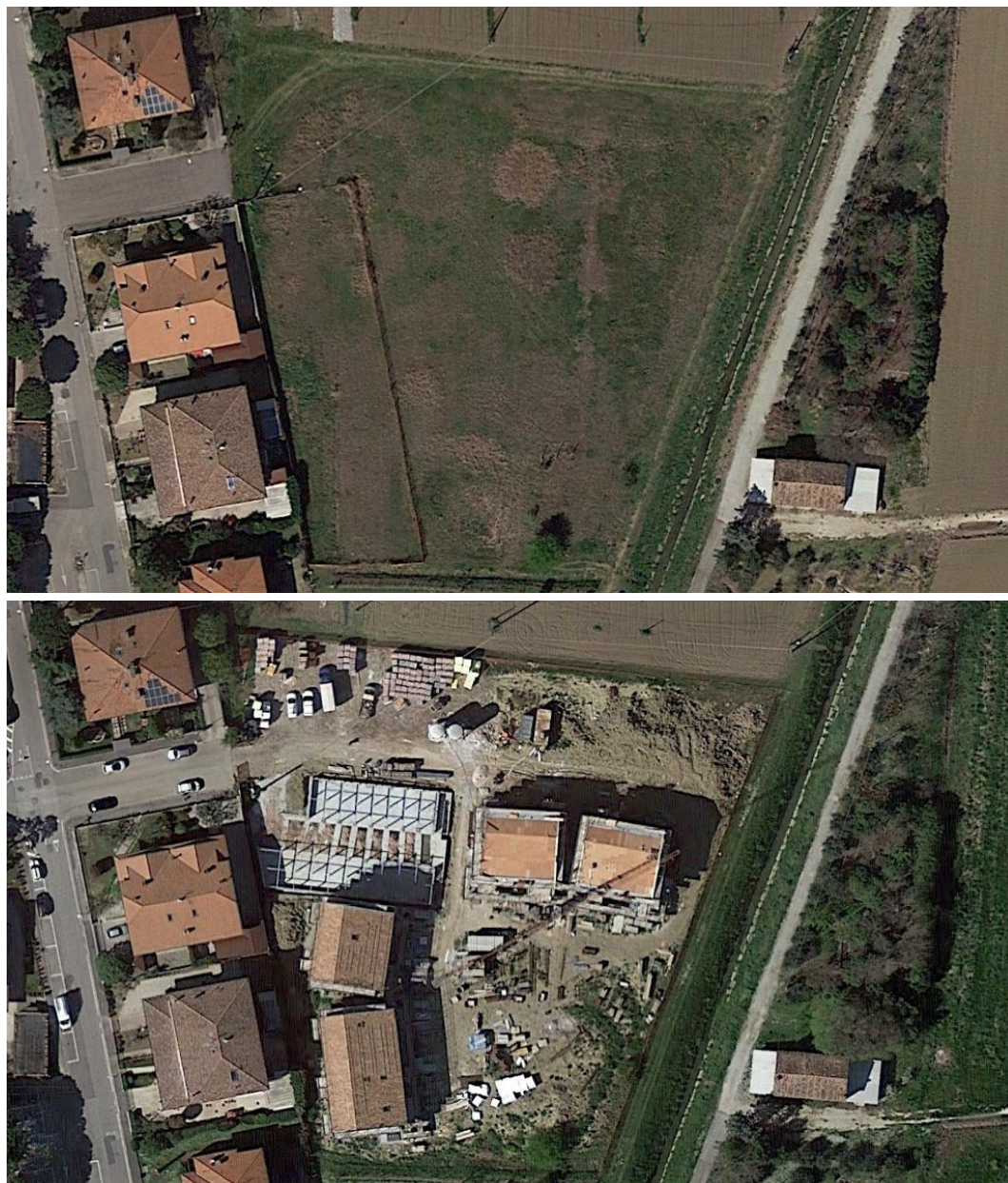
Figura 154. Consumo di suolo per nuovi edifici nel comune di Gatteo (Forlì-Cesena), realizzato in area a elevata pericolosità idraulica. In alto l'immagine è relativa al 2020, in basso al 2022
