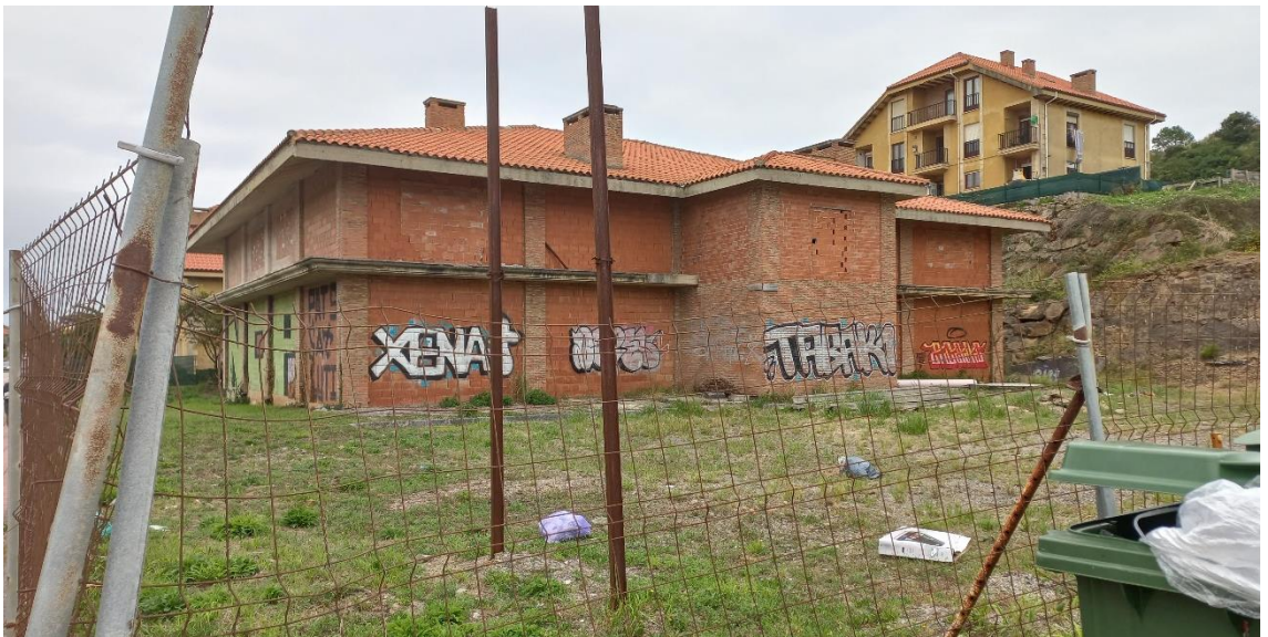
Figura 10. Un edificio abbandonato
