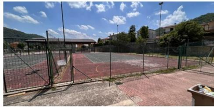
Demolizione campi da tennis - Badia Calavena
