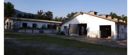
Demolizione fabbricato ad uso stalla - Chiappano
