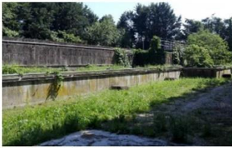
Demolizione ex-depuratore - Camisano Vicentino
