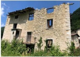
Demolizione fabbricato - Pedemonte
