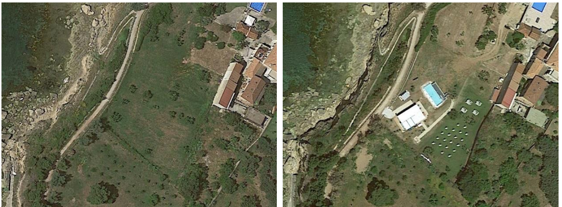
Figura 142. Consumo di suolo all'interno di un'area EUAP, nel comune di Castellabate (Salerno) nel Parco Nazionale del Cilento e Vallo di Diano, per la realizzazione di un nuovo edificio con annesso piazzale. Immagini a sinistra 2019 e a destra, 2022
