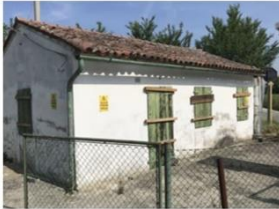
Demolizione fabbricato a Casalserugo
