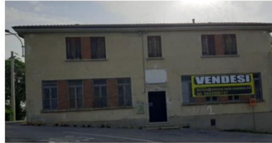
Demolizione ex scuole elementari di Ignago-Isola Vicentina
