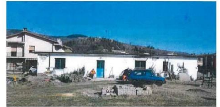
Demolizione di un fabbricato in disuso - Tregnago
