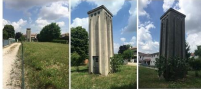
Demolizione della ex cabina ENEL - Povegliano
