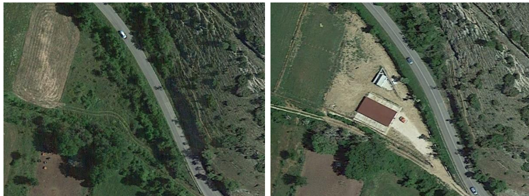
Figura 143. Consumo di suolo all'interno dell'area EUAP (Parco Regionale naturale del Sirente – Velino), Ovindoli in provincia di L'Aquila; per la realizzazione di un nuovo edificio. Immagini a sinistra 2020 e a destra 2022
