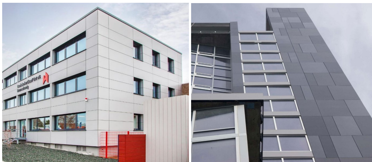
Figura 23 – Esempi di pannelli laminati (HPL). Immagini tratte da trespa.com
