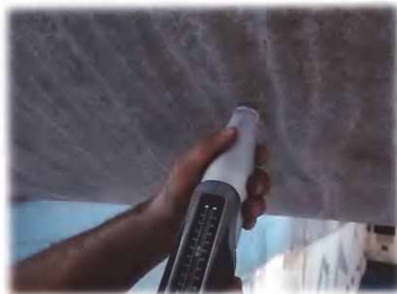
Esecuzione delle battute sclerometriche
