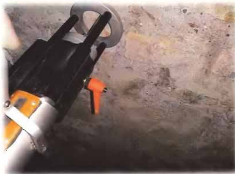
Prova penetrometrica su malta
