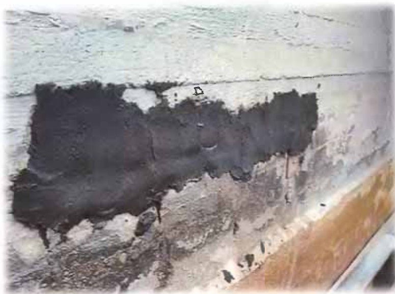
Ripristino strutturale dei carotaggi e dei prelievi di acciaio
