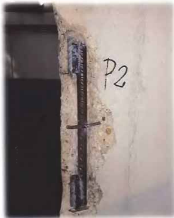
Prelievo del campione di acciaio
