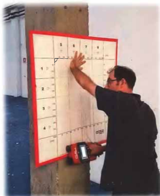
Esecuzione della prova pacometrica
