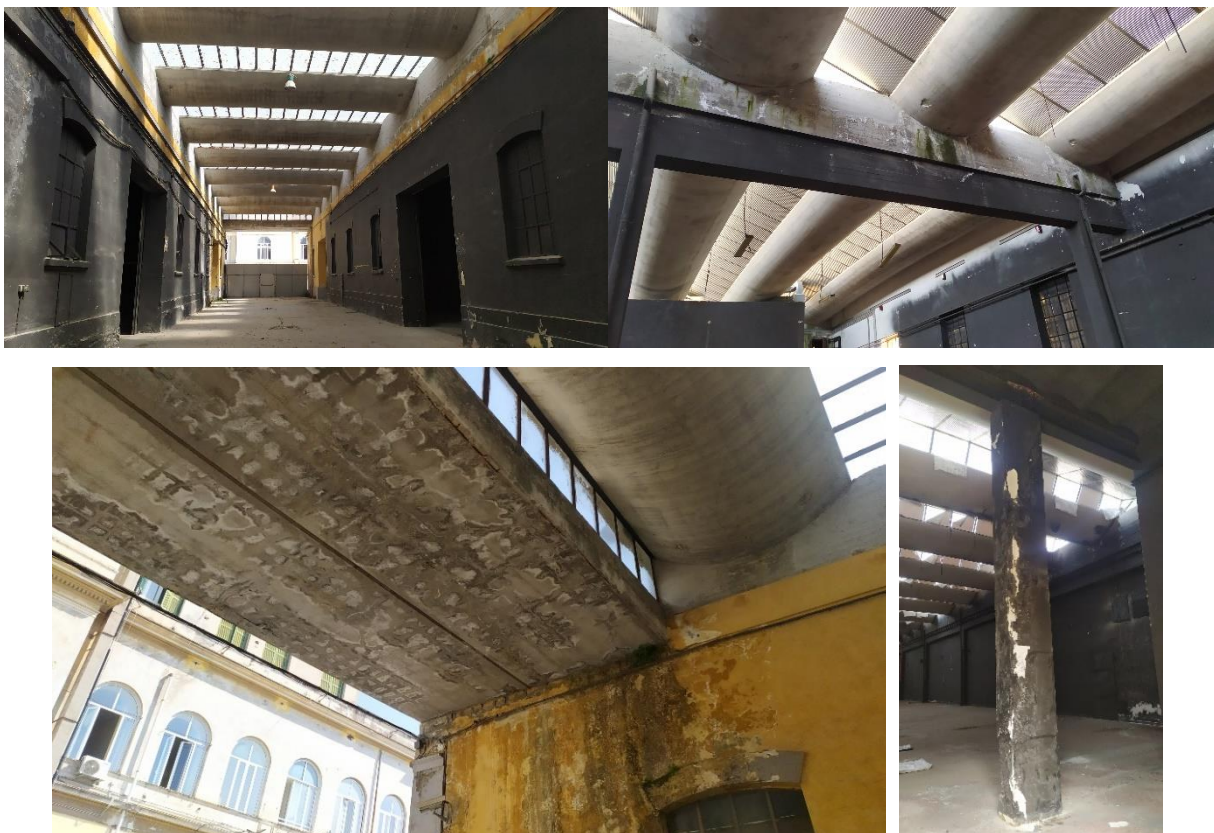
Figura 4.3: Tipologie strutturali delle aree più moderne e stato di conservazione
